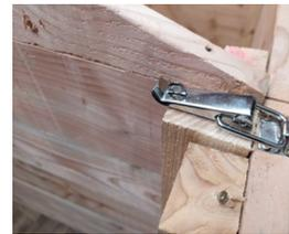
.6 Ajuster l'équerrage de l'ensemble, il doit être impeccable pour continuer. Pousser doucement l'avant à l'aide de la pince à décoffrer tout en maintenant l'arrière pour riper les joues.
